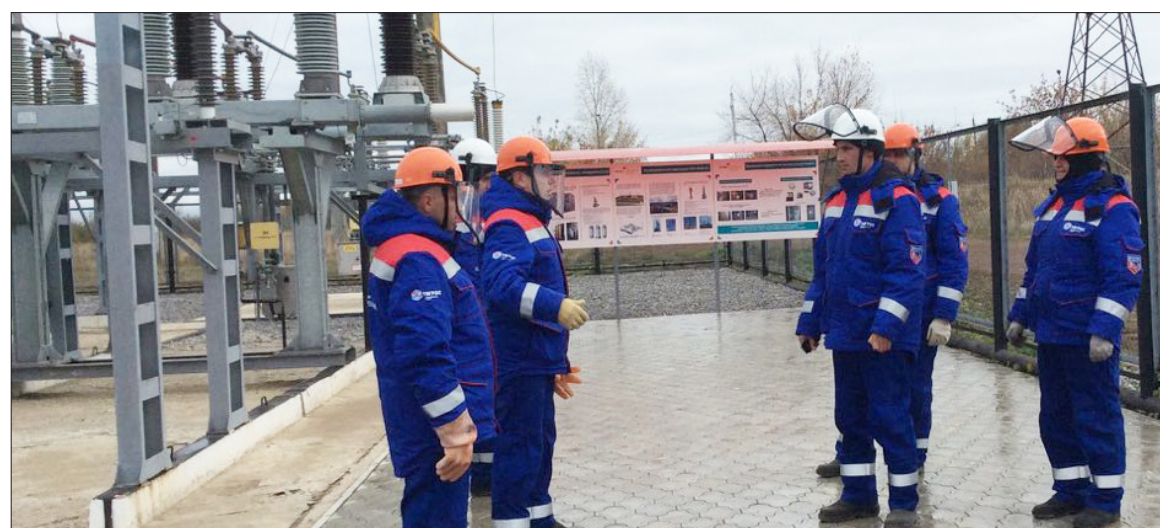
Проведение противоаварийной тренировки персоналами ОДС и персоналом группы подстанций Альметьевского ЭЭС
